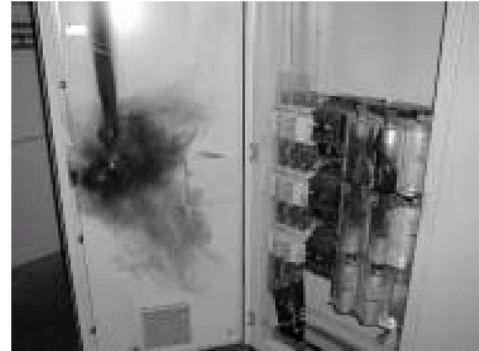
Fig. 5 – Urmările unei rezonanțe necontrolate
